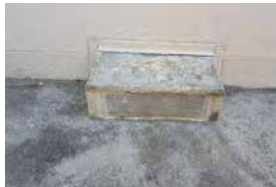
Chatière grillagée interdisant l'accès aux caves pour les chauves-souris
