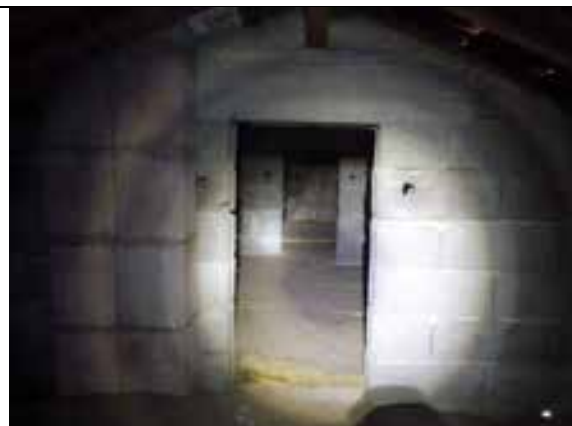
Caractéristiques des combles du bâtiment T5
