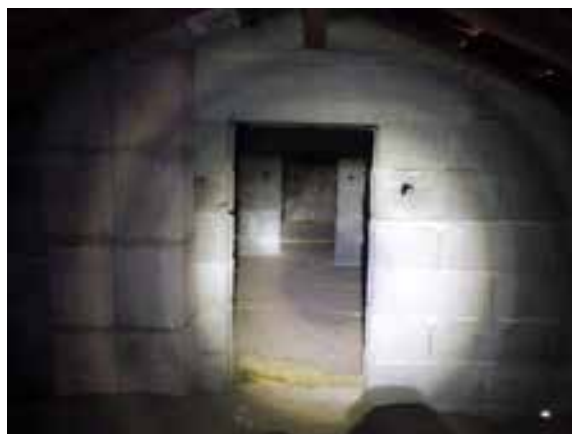
Caractéristiques des combles du bâtiment T5
