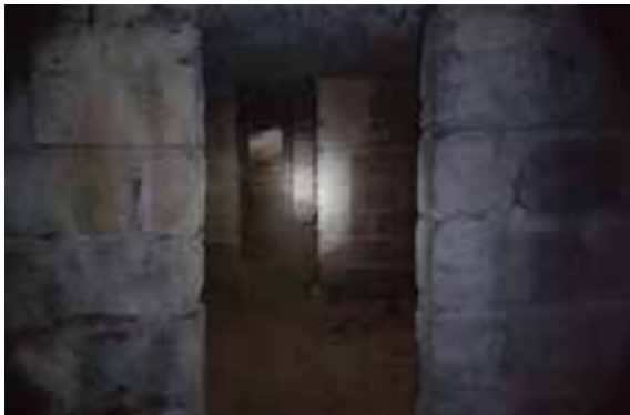
Caves du bâtiment T5
