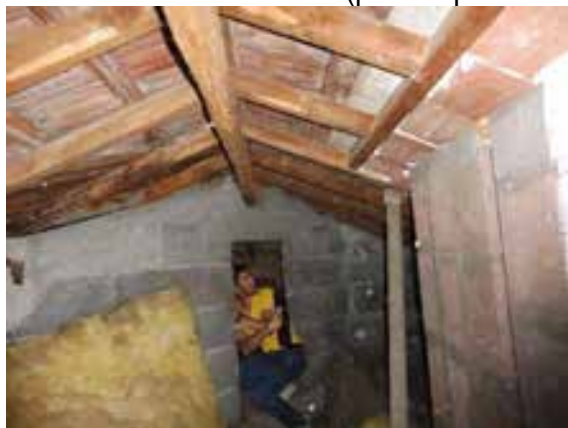
Visite des combles du bâtiment T5
