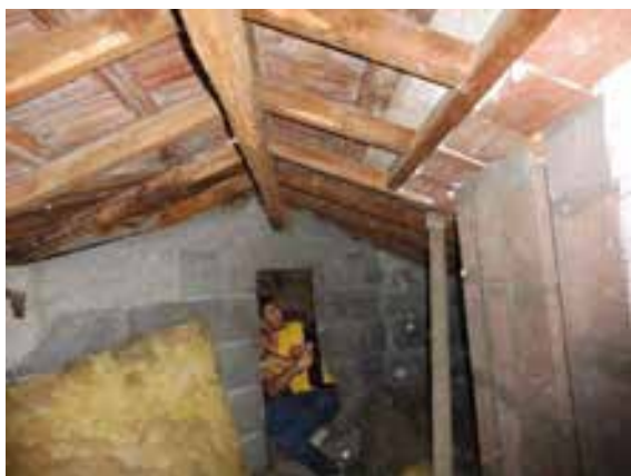
Visite des combles du bâtiment T5
