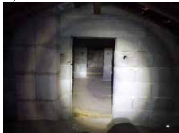
Caractéristiques des combles du bâtiment T5
