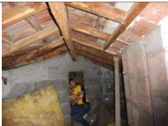
Visite des combles du bâtiment T5
