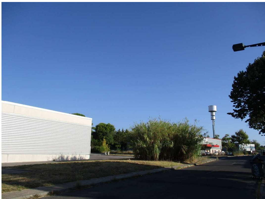
VUE DE LOIN 2 (avant travaux)
