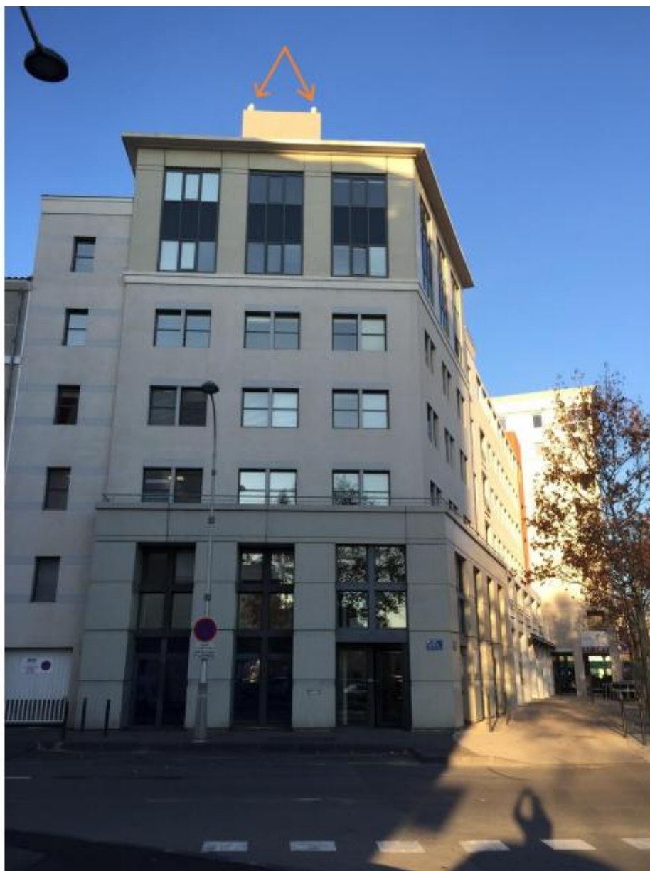
vue 2 : Vue de près. Pas de modification visuelle après le changement des antennes.
